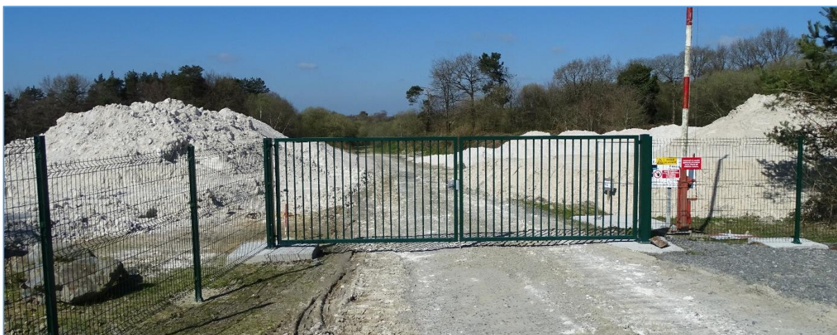
Fig. 24 : Vue sur l'accès au site, fermé par un portail
