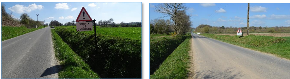
Fig. 27 : Signalisations sur la RD 76 de part et d'autre de la voie d'accès au site
